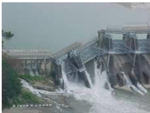
شکل (2-6) آسیب سد شی کانگ (Shihkang) و تخریب پل بزرگراه شماره 13 بواسطه گسلش در زلزله چی چی (Bray, 2001)
