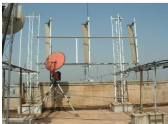
شکل (38-4): آنتن GSM ثابت بر روی بام
