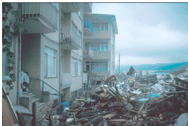
شکل (2-5): تخریب آپارتمانی در زلزله ازمیت ترکیه به واسطه گسلش سطحی (Bray, 2001)
