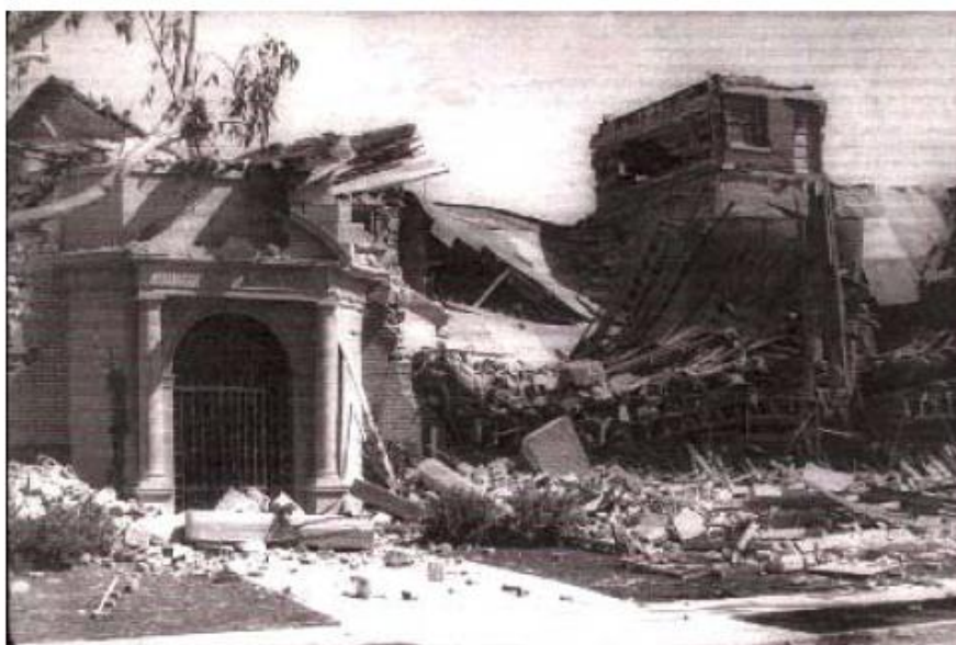
شکل (2-15): نمونه‌ای از مدارس آسیب‌دیده از زلزله لانگ بیچ (دبیرستان جفرسون)
