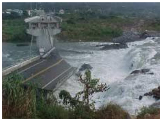
شکل (2-6) آسیب سد شی کانگ (Shihkang) و تخریب پل بزرگراه شماره 13 بواسطه گسلش در زلزله چی چی (Bray, 2001)
