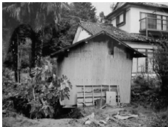
شکل (2-9): نمونه‌هایی از فرونشستهای ناشی از زلزله 1993 میاگی-هوکایدو در محل معادن لیکنیت (Aydan, 2004)
