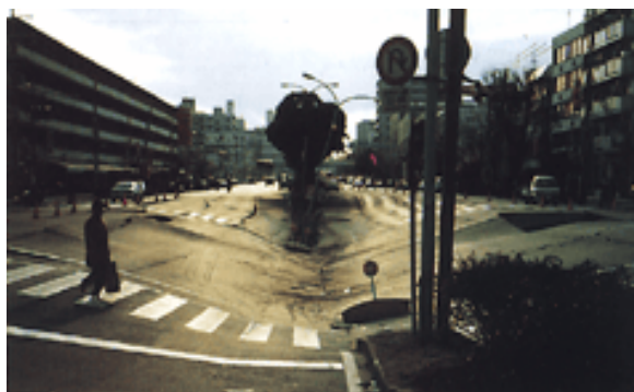
شکل (2-10): فرونشست زمین در ایستگاه متروی دایکایی ناشی از زلزله 1993 کوبه
